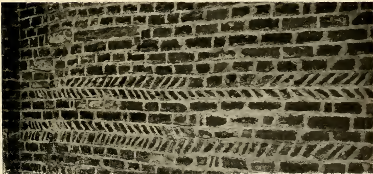
Fig. 340 — Struttura esterna dell'abside maggiore di Sant'Ambrogio a Milano (a. 789-824)
